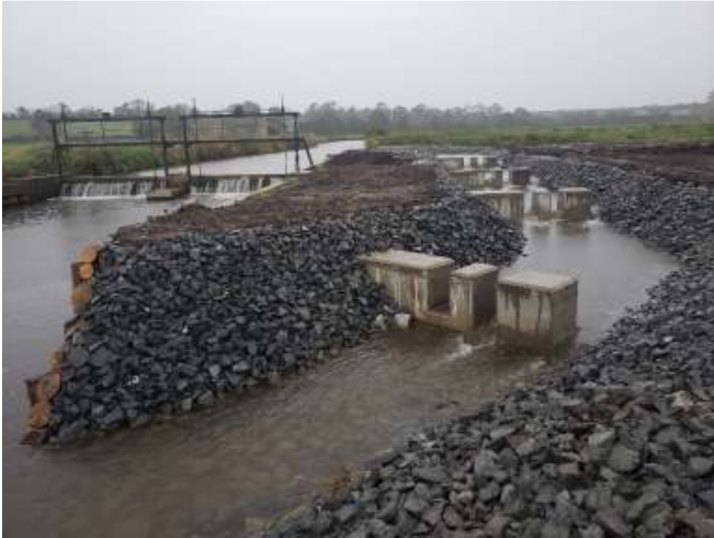
Figure 36 : Rivière de contournement aménagée sur l'ouvrage du pont de l'Acre (source : FDAAPPMA 14)
